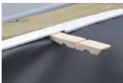
Verrouillez la pose au fur et à mesure de la progression à l'aide de demi-épingles à linge en bois (non fournies), et ce plus particulièrement au niveau des angles ([Figure 28](#)).
