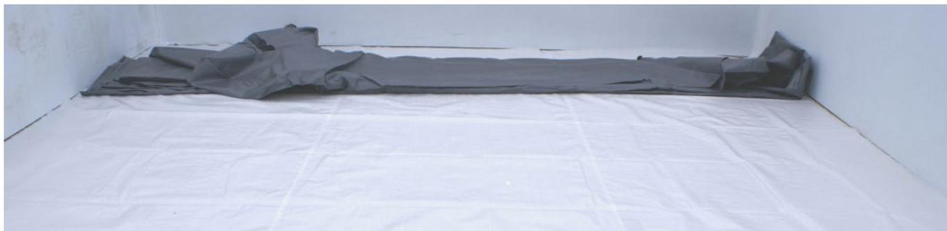
Figure 27 – Dépliage du liner
