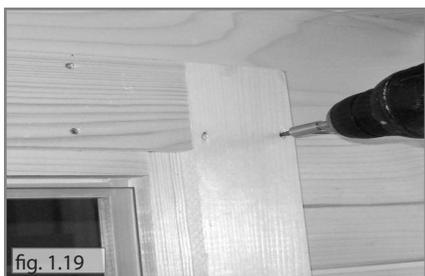
14. Fixez les baguettes de revêtement intérieures et extérieures sur le chambranle et le coté de la porte. (vis 3x40) La distance entre baguettes et chambranle doit être de 12 mm sur tous les cotés. (fig.1.19)
