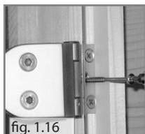
11. Vissez le cadre aux parois (vis 4x70 – fig.1.15) Sur le côté de la bande vous pouvez visser le cadre par le trou au milieu de la bande. (fig.1.16)
