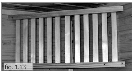
9. Pour l'éclairage de la cabine, percez un trou d'un diamètre de 10 mm dans le coin gauche ou droite de la paroi arrière. Après le branchement de la lampe vous fixez la protection diagonalement à l'aide de 4 vis, comme vous le voyez dans fig.1.13.(vis 3x40)
