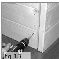
2. Prenez le madrier de devant avec ouverture pour la porte et placez la paroi étroite de la droite au-dessus. (Cet élément a une baguette saillant en bas à droite – fig.1.2) Vissez de devant le madrier inférieur à la baguette (vis 3x40 – fig.1.3) et du coté avec le coté extérieur.
