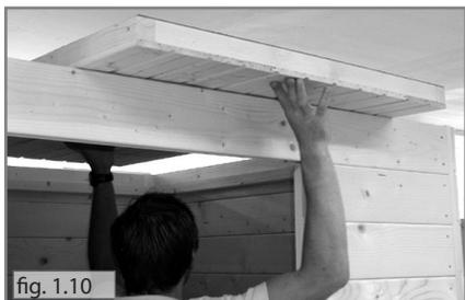
7. Après le montage des plinthes placez les deux éléments de toit sur celles-ci (fig.1.10 + fig. 1.11) et vissez-les par le dessus de la cabine. (vis 5x80)
