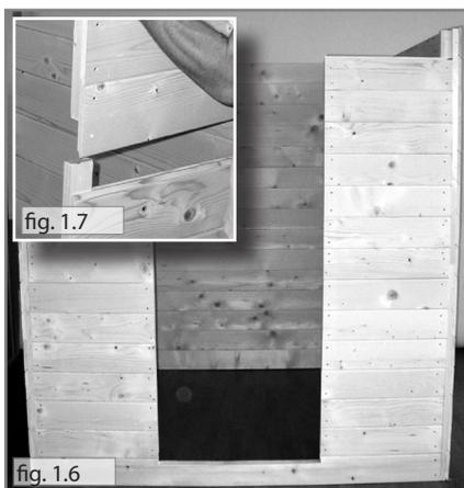
4. Mettez la paroi arrière et gauche (pièce II) sur les parois inférieures et vissez-les du côté. (vis 5x80) Vérifiez qu'on ne peut pas voir les vis de l'intérieur.
