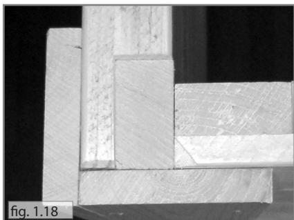
13. Après le montage de la porte fixez les baguettes de revêtement. Commencez par la baguette à gauche de la porte et fixez après la deuxième baguette au coin (90° - vis 3x40 - fig.1.18).
