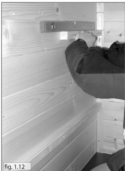
8. Montez les pièces de support. Fixez les supports inférieurs (4x4x100) à gauche et à droite de la porte à une hauteur de 41 cm mesuré du sol jusqu'au bord supérieur du support. (vis 4x70)
