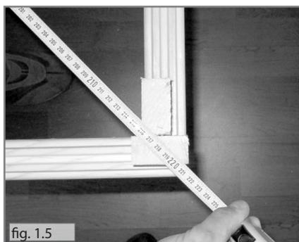
3. Contrôlez si la cabine a des angles droits. Pour cela, mesurez diagonalement la longueur sur les deux cotés, qui doivent être pareils. (+/- 2 mm - fig.1.5)
