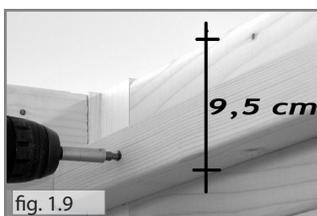
6. Maintenant fixez les plinthes de support sur les paroi. Pour cela, mesurez 9,5 cm du bord des parois jusqu'au bord inférieur des plinthes. (vis 4x70 - fig.1.9) L'arrondissement des plinthes doit être visible en bas.
