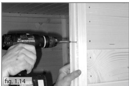
10. Prenez la porte avec chambranle et mettez tout dans l'ouverture. L'ouverture de la porte peut être positionnée à gauche ou à droite. Pour cela, tournez la porte de 180°. Assurez-vous que le cadre de la porte et la façade s'ajustent exactement et il ne saillit rien. (vis 4x70 – fig.1.14)
